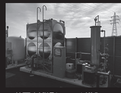
井戸水濾過システム導入
