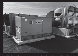
非常時における自家発電機導入
